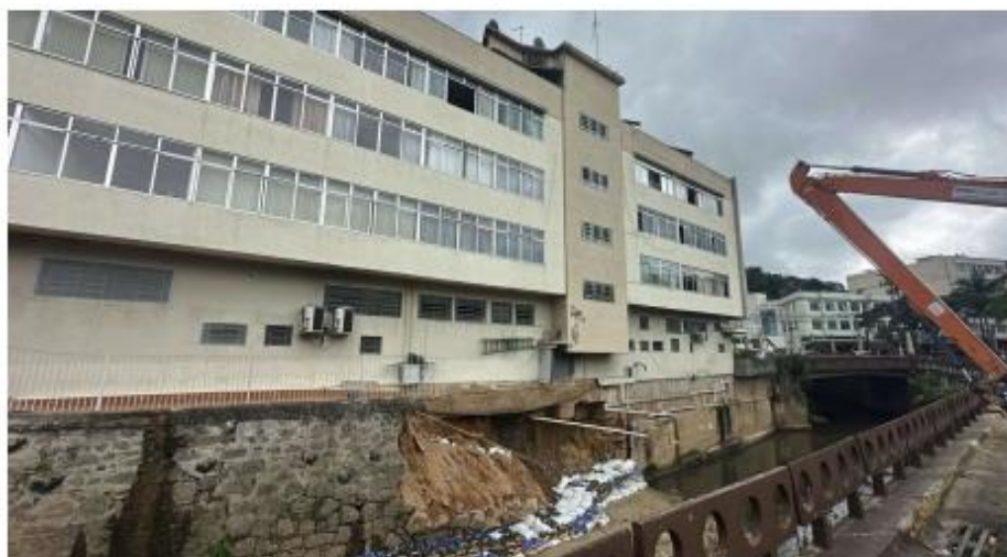
Figura 44 Foto do muro colapsado nas margens do Rio Imbuí/Paquequer
